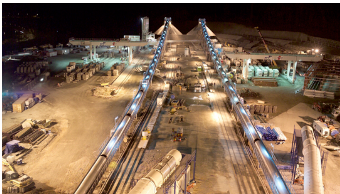
Instalaciones de obra . Túneles de Pajares (FCC)
