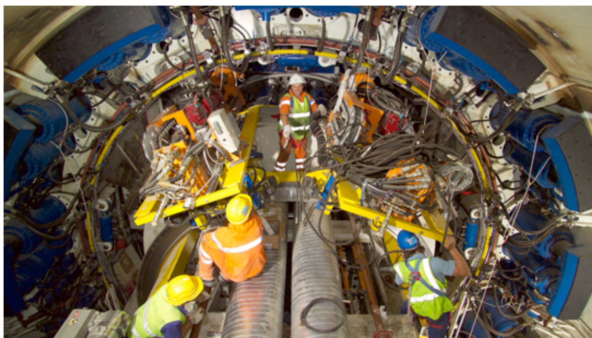
Montaje de la cabeza de la tuneladora. Túneles de Guadarrama (FCC)
