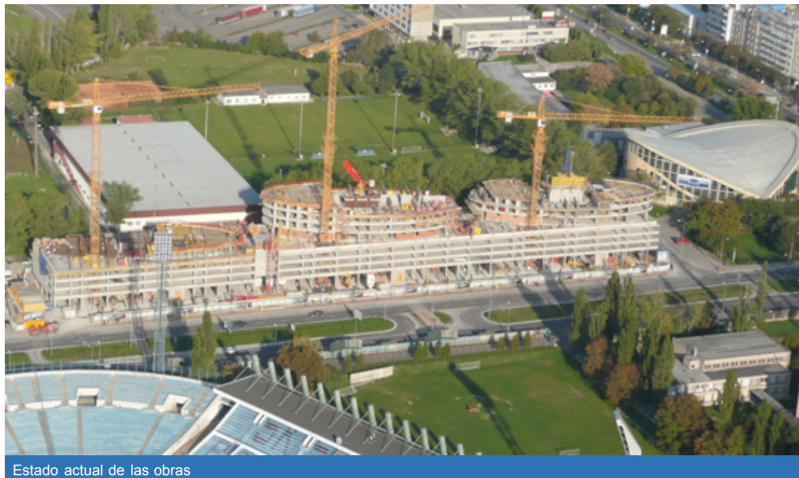
Estado actual de las obras
